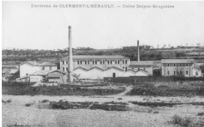
L'usine de draps Delpont-Bruguère dans les environs de Clermont l'Hérault, fermée dans les années 1960
