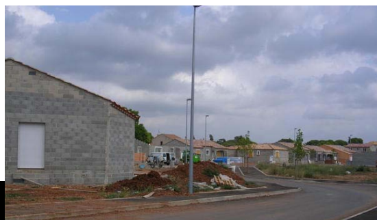
Lotissement en construction à Brignac
