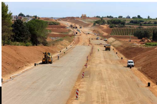
Travaux de l'A75
