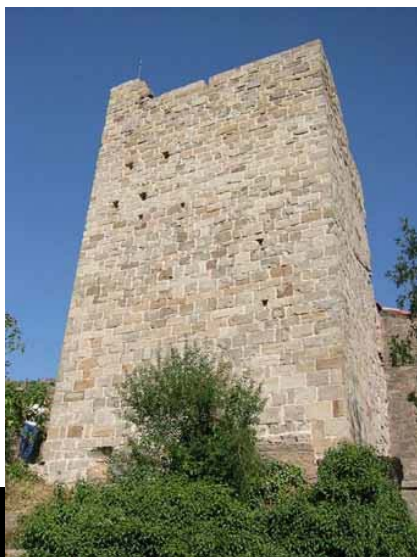
Restauration de la tour d'Olmet et Villecun
