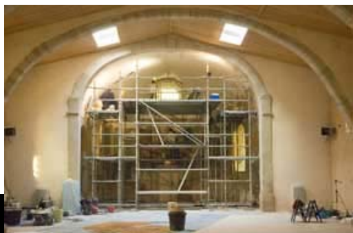
Restauration de l'église du Barry à Montpeyroux
