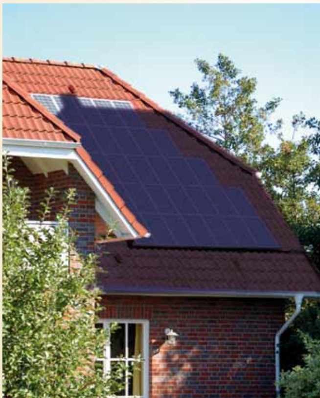
Installation de panneaux photovoltaïques dans l'ombre
