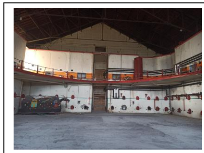
Cuve en forme de fer à cheval
