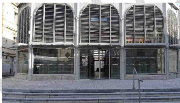
Intérieur et extérieur des halles de Frontignan après travaux
