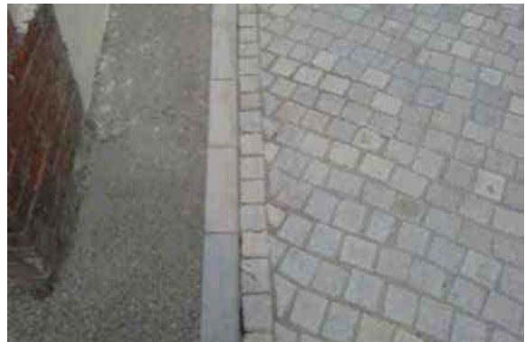
exemples de marquage des pieds de façade, intégrant une bordure réhaussée servant de guide pour les personnes non voyantes
